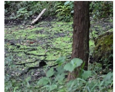
図2 弁天池 2025/10/21 ひび割れ、植物が覆う
