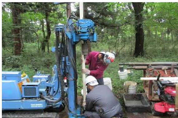
掘削した穴に館を埋め込み中です。
