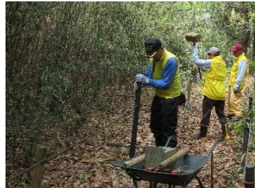
生物多様性を確実に保全 園路の整備
