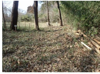
傷んでいる木道を撤去
